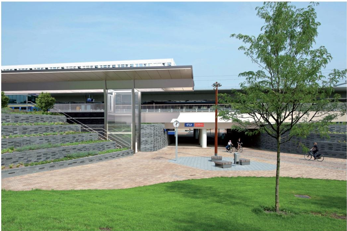
Station met nieuwe perronkap en lift – Helperzoomzijde
